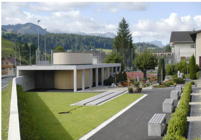
Im Rahmen der teilweisen Umgestaltung des Friedhofs in Escholzmatt entstand unter anderem ein neues Abdankungsgebäude. Eine streng geometrische Sichtbetonkonstruktion mit Stützen dient als schützende Vorhalle, umfasst das Hauptvolumen und überdacht die Ökonomieräume. Der ellipsenförmige Hauptkörper aus einheimischem, unbehandeltem Fichtenholz dient als Aufbahrungsraum. Durch den ringsum laufende Fensterkranz fällt weiches Licht von oben in das schlicht gehaltenen Innere.
